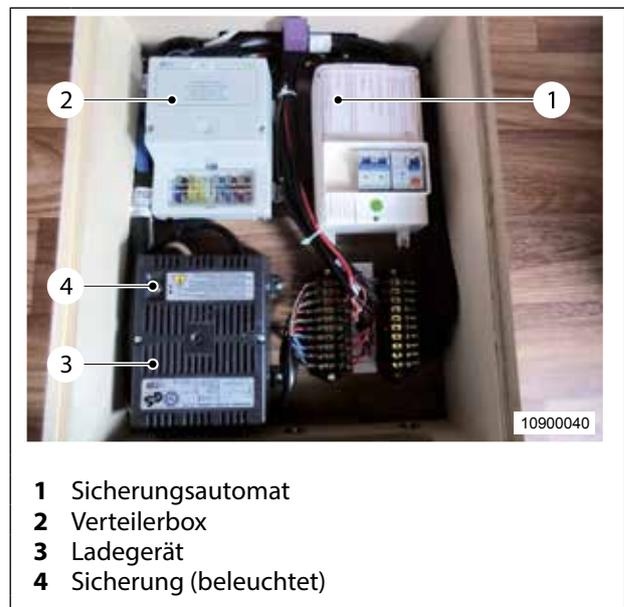
Abb. 39 Elektroeinheit
